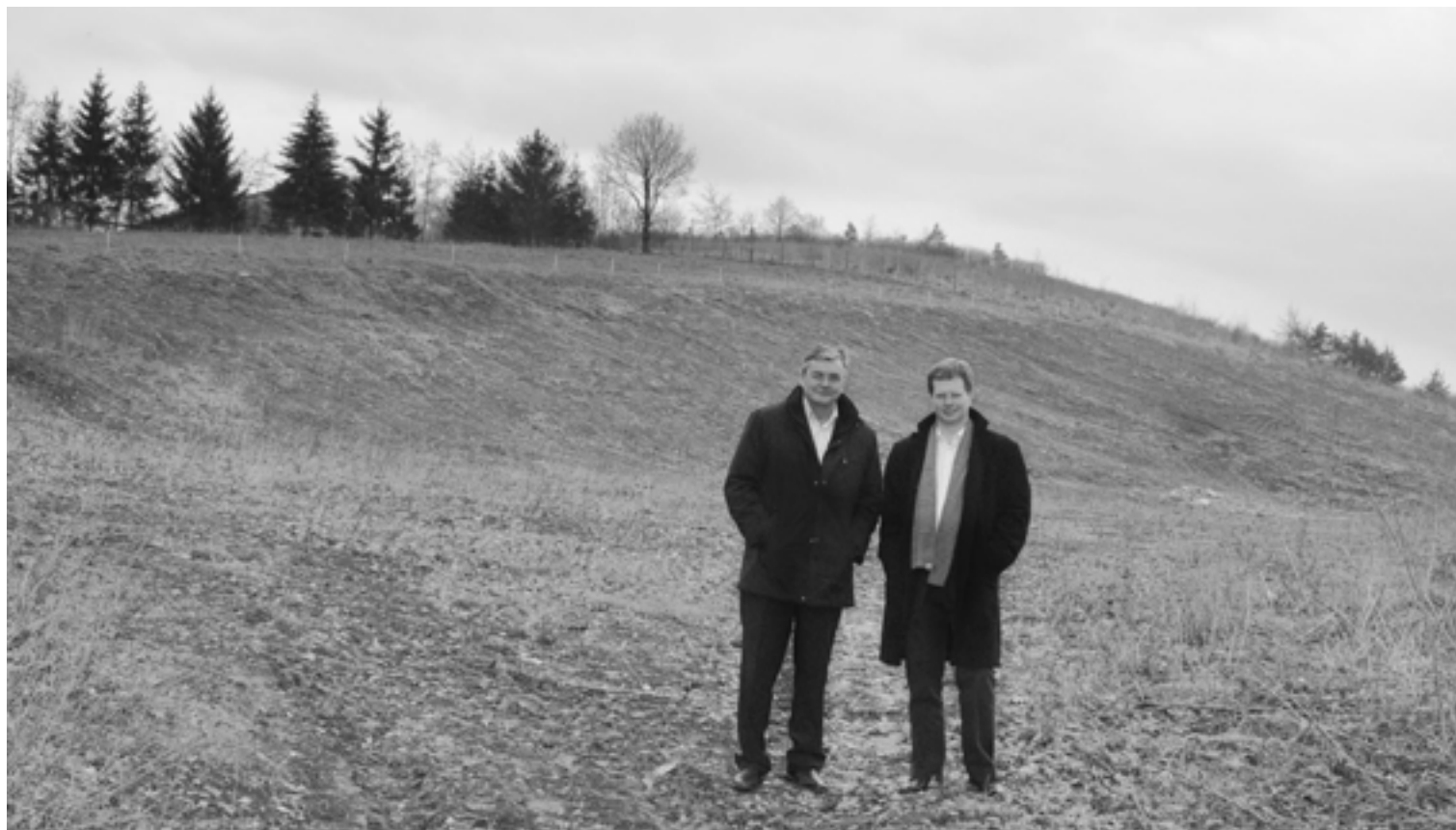
Z Marcinem Godzińskim na placu budowy parku technologicznego w Nowym Sączu
