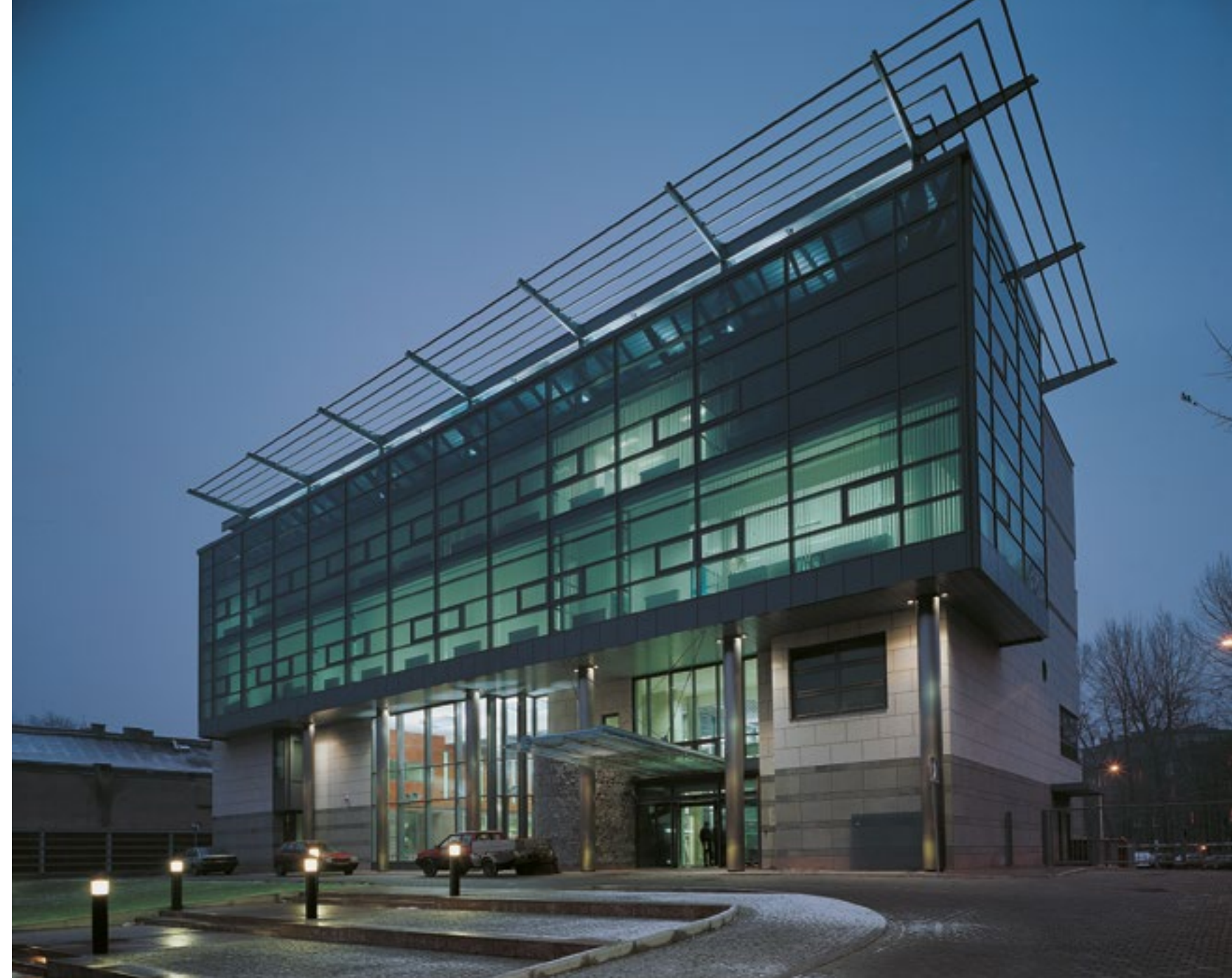
Budynek krakowskiego oddziału Banku Handlowego w Warszawie, projekt 1995–1996, realizacja 1997
